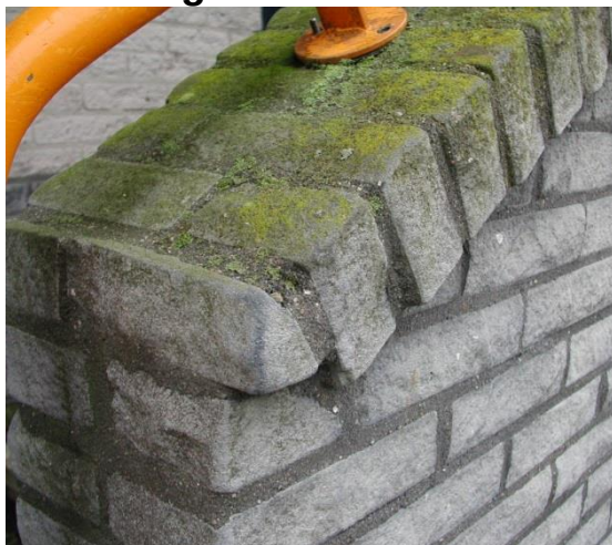
Algen en mossen op een rollaag (2.4.a)
