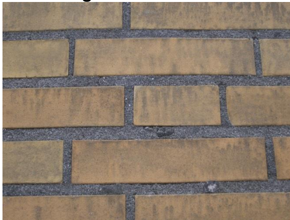
Neerslag van losse ijzerdeeltjes en organische Deeltjes (2.3, 2.5.a)
