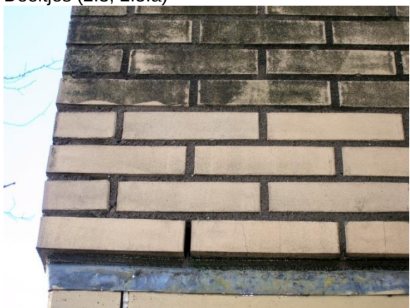
Atmosferisch vuil op een gladde, dichte steen (2.3.b)
