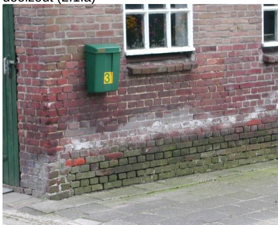
Uitbloei van nitraat op een stal (2.1.a)
