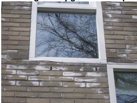
Uitbloei van oplosbare zouten uit de steen (2.1.b)
