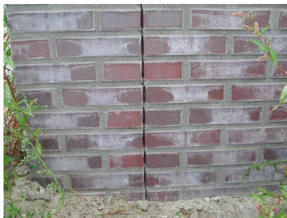
Witte afzettingen door uitloging van de metselmortel (2.1.b)
